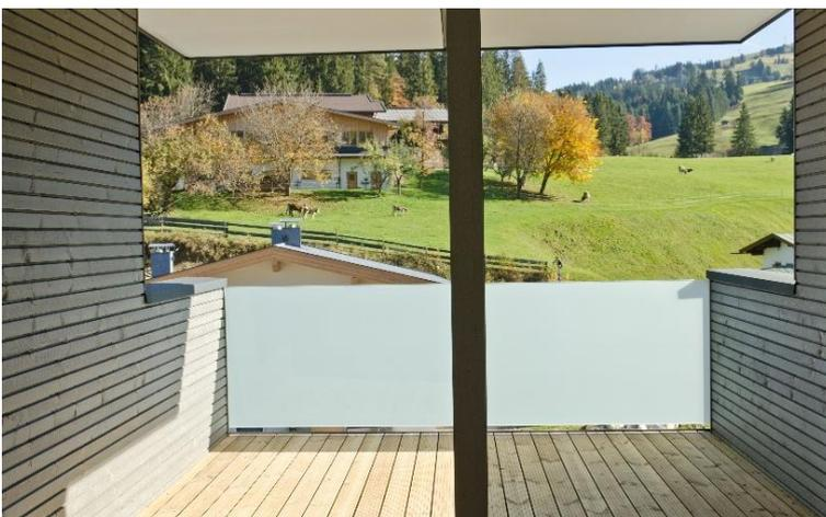
Abbildung 15: Balkondielen in Thermokiefer bzw. gleichwertiges Material
