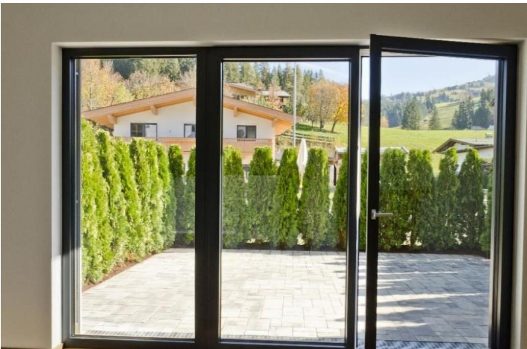
Abbildung 6: Kunststoff-Alu-Fenstertüren mit 3-Scheiben-Wärmeschutzverglasung teilweise fixverglast
