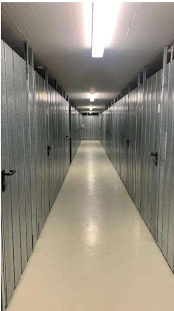
Abbildung 13: Epoxybeschichtung in den Kellerräumen
