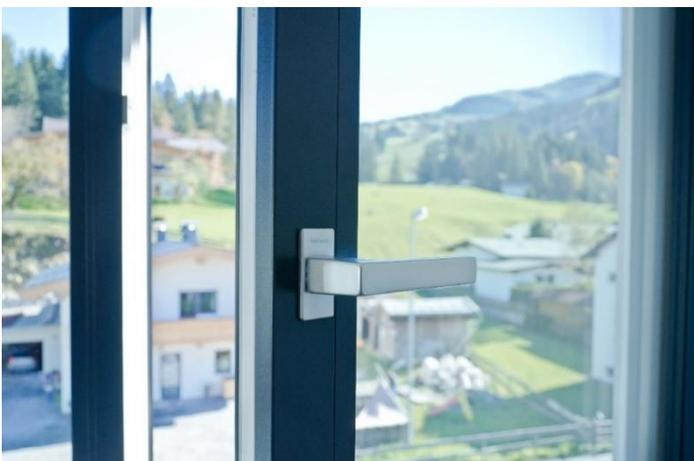
Abbildung 3: Kunststoff-Alufenster mit 3-Scheiben-Wärmeschutzverglasung (U-Wert Glas: 0,6 W/m<sup>2</sup>K)
