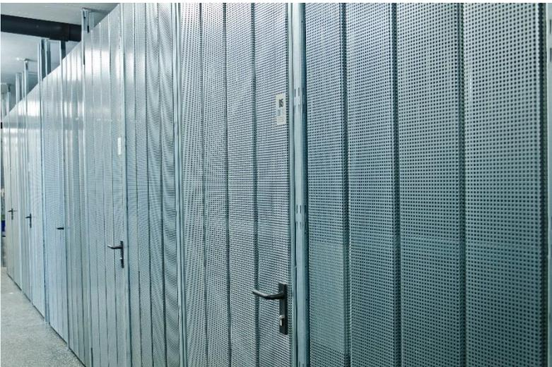
Abbildung 21: Verzinktes Stahllochblech mit versperbarer, flächenbündiger Türe bzw. vergleichbare Ausführung
