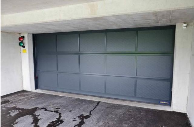
Abbildung 43: Alu-Sektionaltor mit Chipsystem, Funkfernbedienung und Belüftungsgitter, Fa. Hörmann oder ähnliches Produkt
