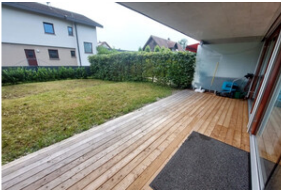
Terrasse mit neuem Lärchenholzrost
